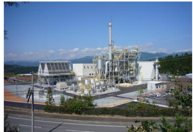
日田ウッドパワー日田発電所
