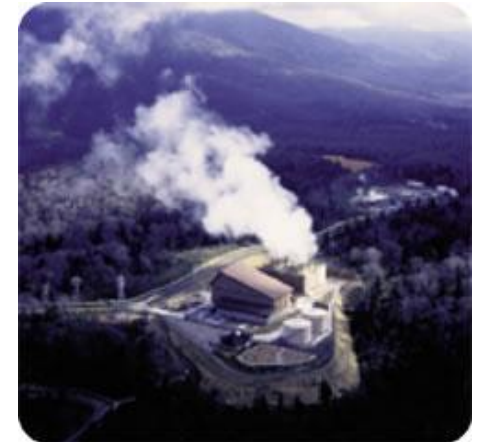
澄川地熱発電所
