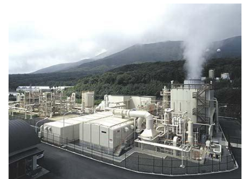
八丈島地熱発電所
