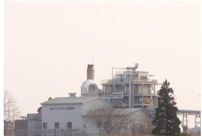
能代バイオ発電所
