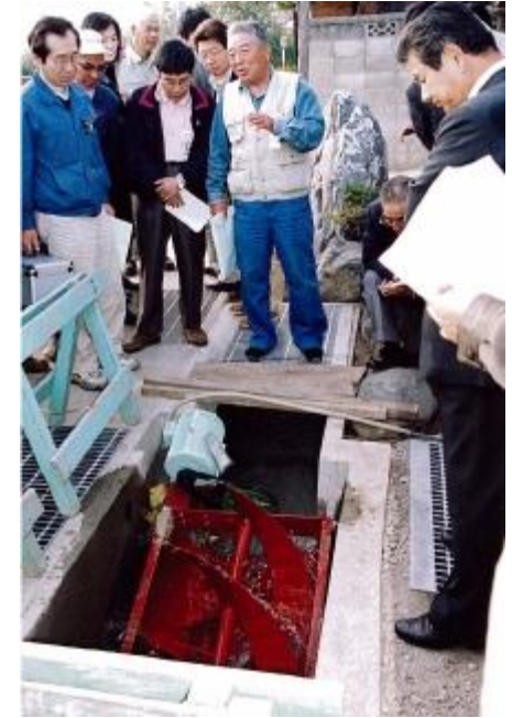
川上水力発電所
